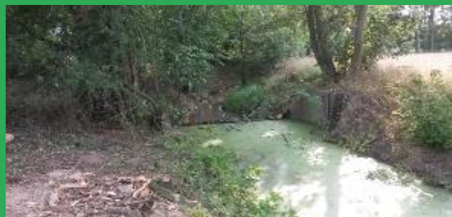
Po opravě náhonu
