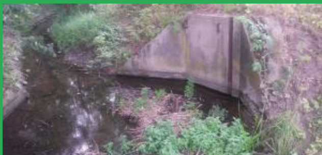
Před opravou náhonu
